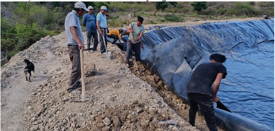
Einebnen, Verdichten und Sammeln der Steine auf der gesamten vorbereiteten Fläche.
