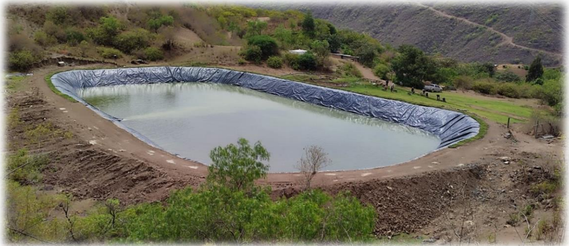
Die Dichtungsbahn mit einer Wasserbelastung von 70 % der gesamten Wasserspeicherkapazität
