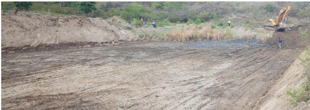
Profilierung der Seitenwände der Mikrolagune und Vertiefung der Lagune auf eine Tiefe von 3,3 m.
