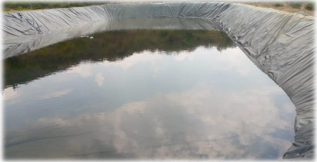
Die Dichtungsbahn mit einer Wasserbelastung von 70 % der gesamten Wasserspeicherkapazität
