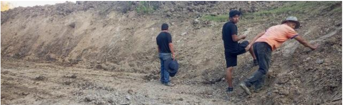
Einebnen, Verdichten und Sammeln der Steine auf der gesamten vorbereiteten Fläche.
