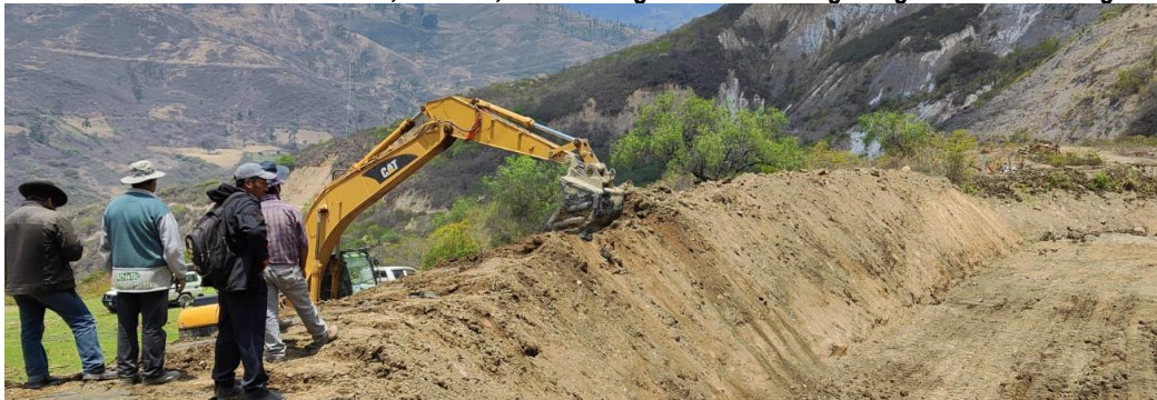
Profilierung der Seitenwände der Mikrolagune und Vertiefung der Lagune auf eine Tiefe von 3,3 m.
