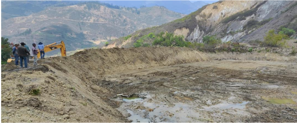
Feldarbeiten mit schweren Maschinen, Aushub, Nivellierung und Profilierung der gesamten Mikrolagune.
