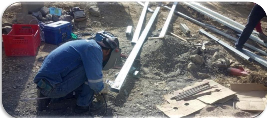
*BRUNNEN NR. 3, INSTALLATION DER 36 SOLARMODULE MIT EINER LEISTUNG VON 75 WATT,*
