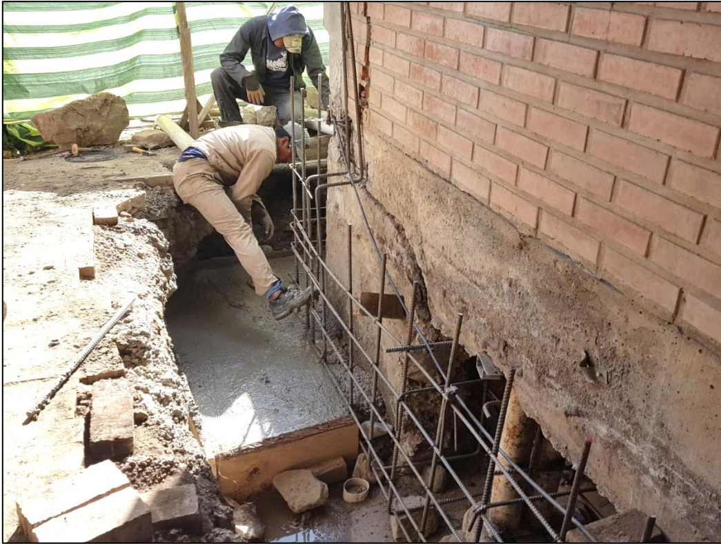
Abb. 6: Anbringung von Metallstrukturen entlang der betroffenen Außenwand und erste Zementierung
