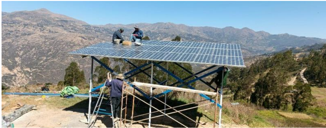
Die Arbeiten zur Installation der Solarmodule für die photovoltaische Pumpanlage
