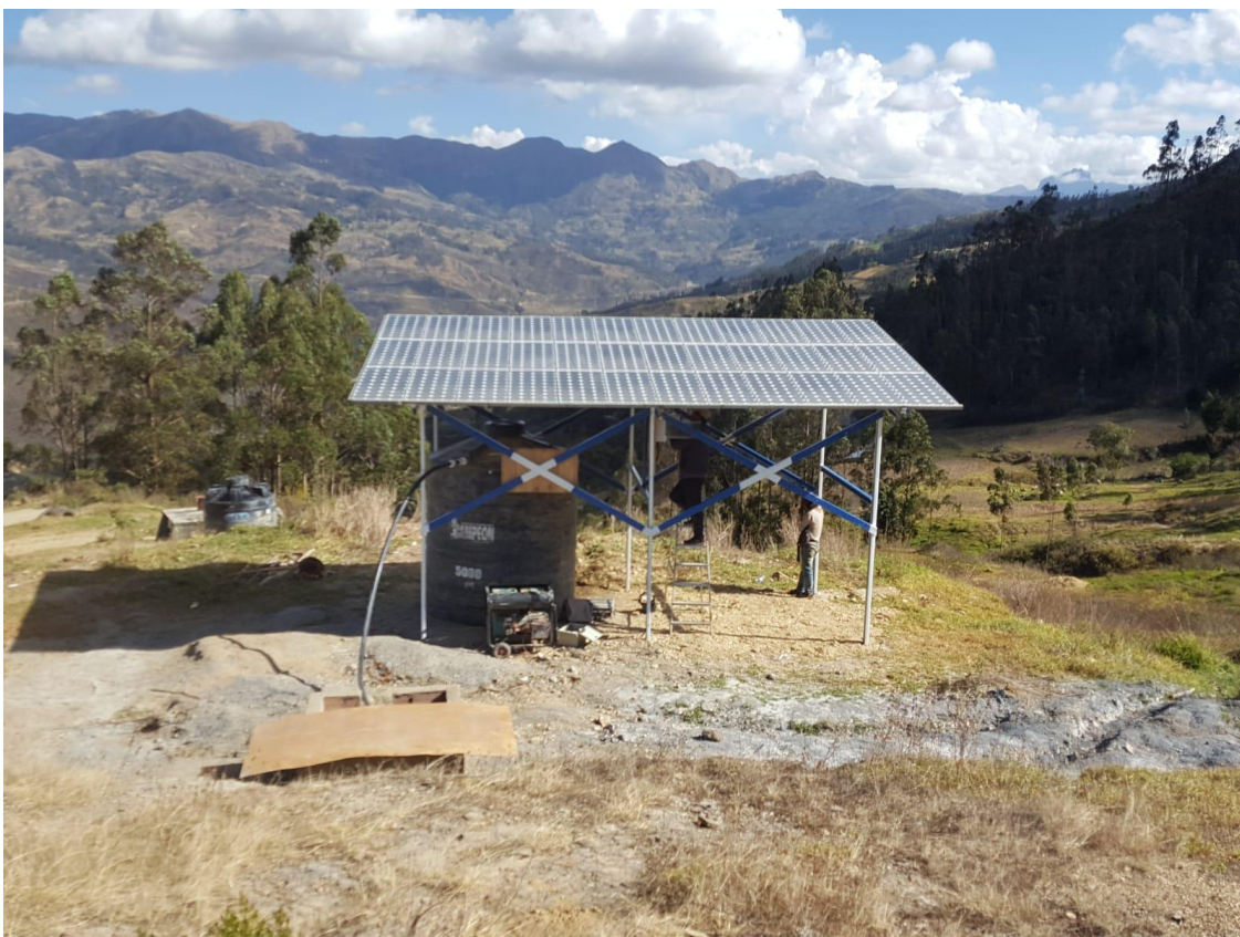
Montage von Photovoltaikmodulen für die solare Wasserförderung in Aramani, Mitarbeiter von CCA.
